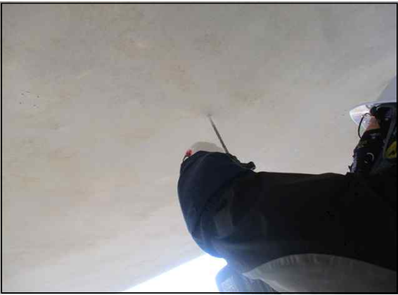
탄산화 시험 (천공)
