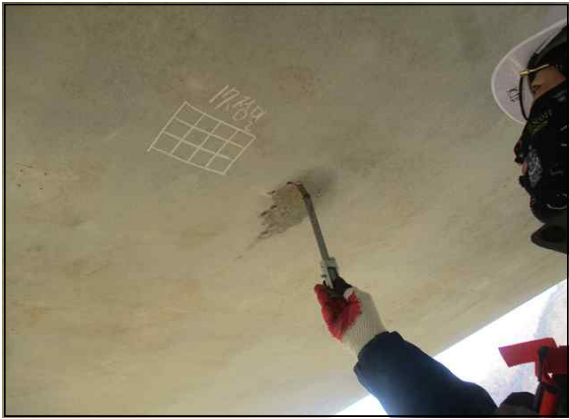
탄산화 시험 (깊이 측정)
