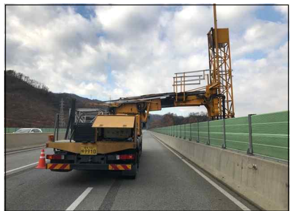
작업차량을 이용한 외관조사
