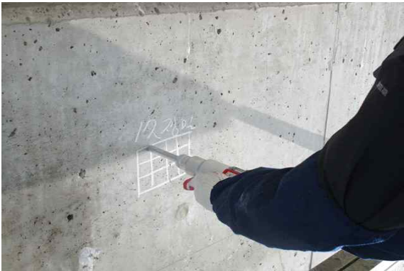
교각 압축강도 측정
