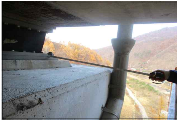
교량받침 연단거리 측정 현황
