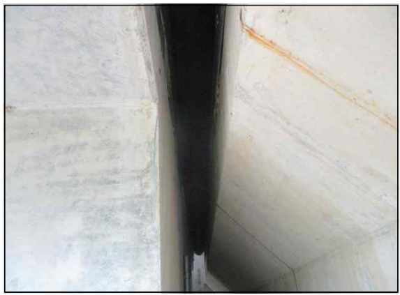
신축이음 하부 전경(A1)
