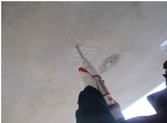
거더 압축강도 측정
