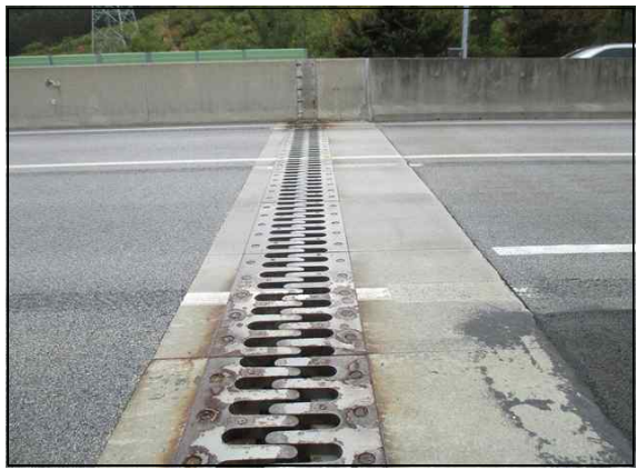
신축이음 상부 전경(A1)
