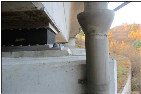
교량받침 연단거리 측정 현황
