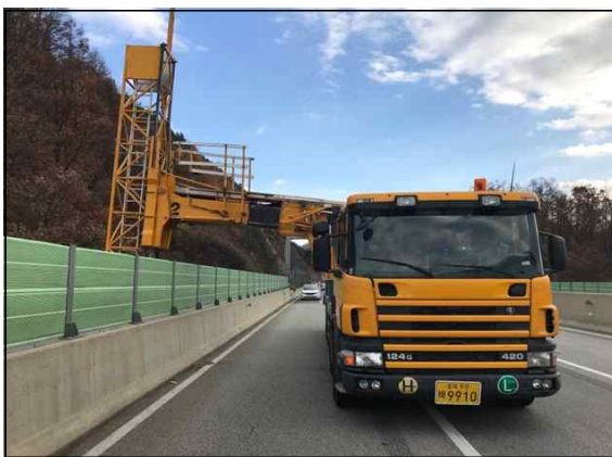
작업차량을 이용한 외관조사
